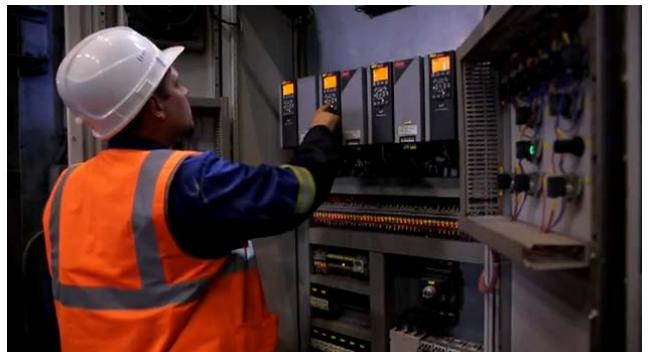
На сегодняшний день в Оленегорском ГОК современное оборудование уже установлено на наиболее энергоемких объектах, среди которых мощные дробилки, конвейеры, насосные группы. За счет внедрения в электрические схемы преобразователей частоты и устройств плавного пуска достигнута оптимизация технологических процессов.
